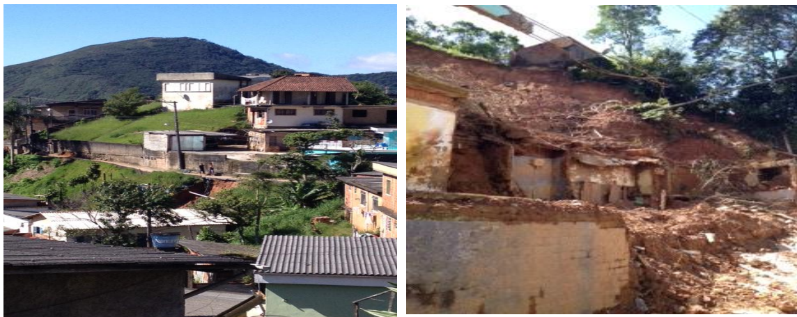
Foto 3 - Ao fundo, observa-se um caminho de passagem dos moradores, carente de iluminação pública. (à esquerda)
