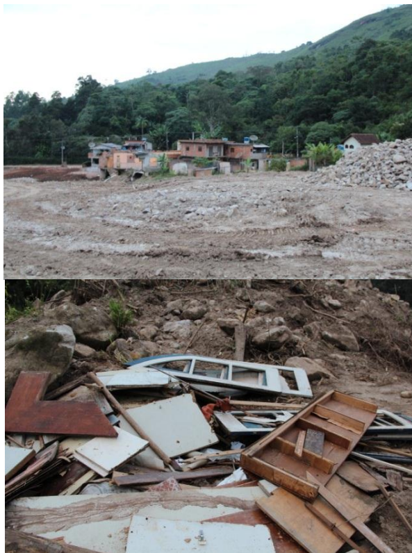
Fotos 10 e 11: Terraplanagem feita na área e vestígios da devastação.
