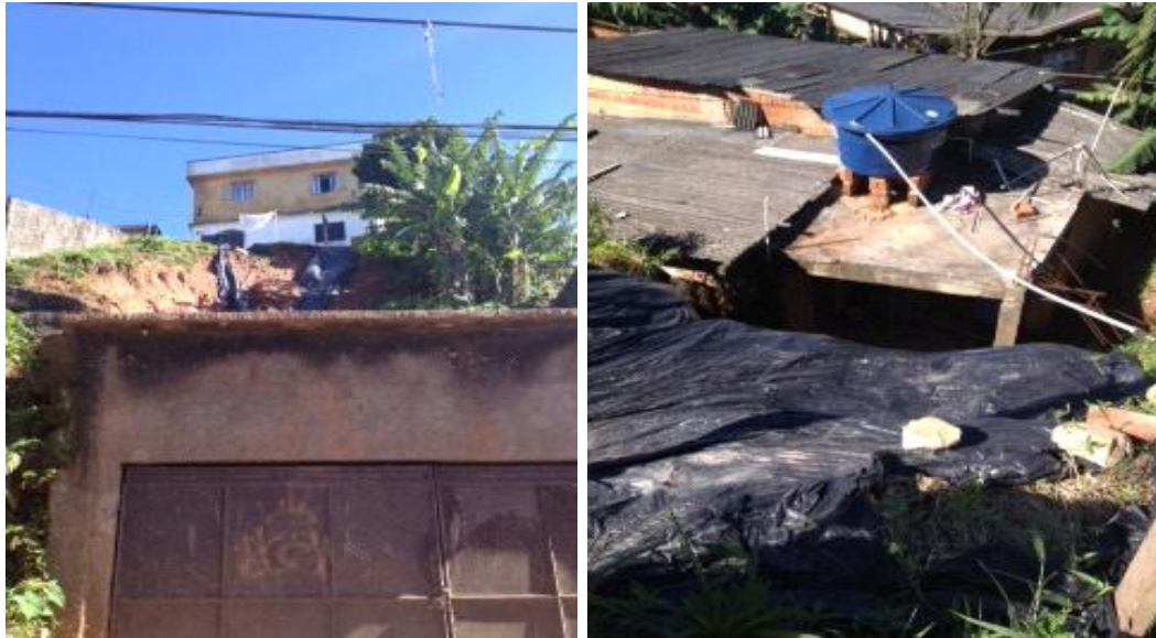
Foto 01 – Áreas ainda sem muros de contenção (à esquerda)
