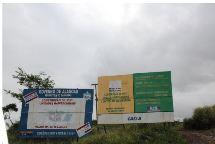
Placas informativas das obras do conjunto Residencial Mundaú, com 1053 unidades.
