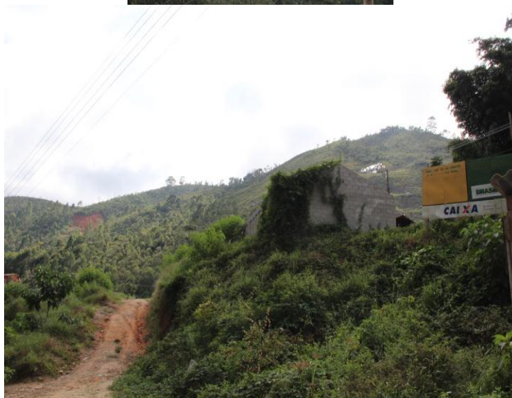
Fotos: Loteamento Granja Spinelli. Obras interditadas. Deslizamento de terra ao fundo.
