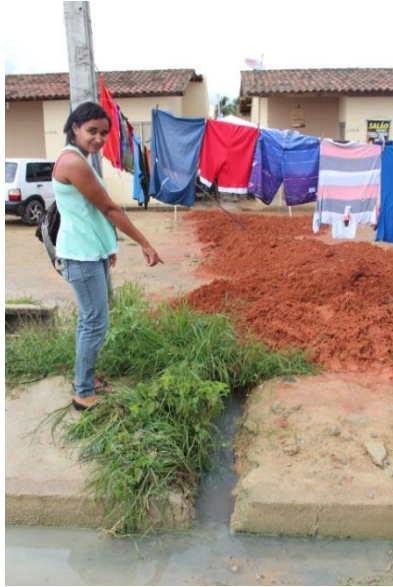
Esgoto a céu aberto
