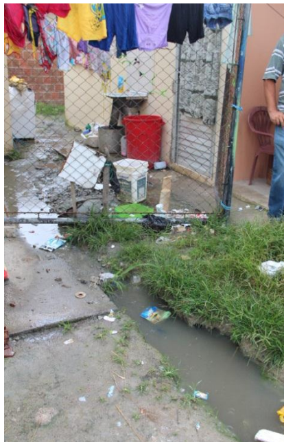
Falta de escoamento da água e esgoto entre as residências
